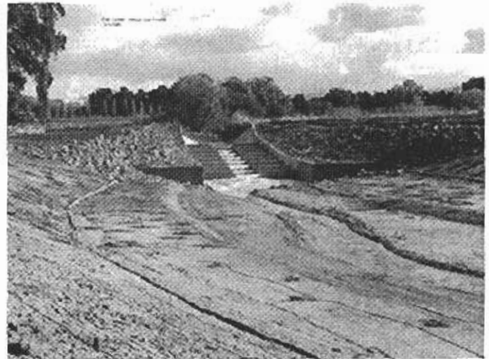
Arroyo Las Positas Fish Ladder
